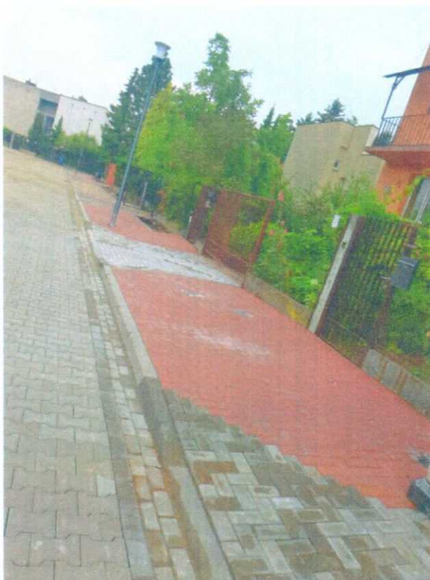
Fot. 2. Chodnik i wjazd do posesji z zachowaniem spadków zgodnych z przepisami technicznymi.
