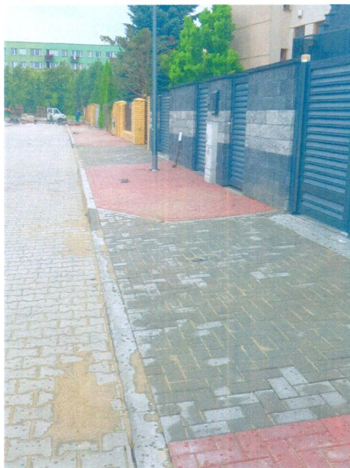
Fot. 4. Wykonane chodniki i wjazdy do nieruchomości i ich połączenia z posesją. Zachowane spadki zgodne z przepisami technicznymi.
