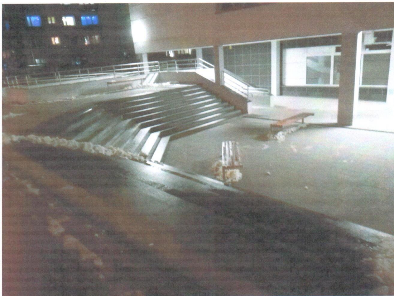
Fot. 1 Zdjęcie schodów, które stanowią barierę architektoniczną dla osób starszych i wymagających asekuracji – brak poręczy
