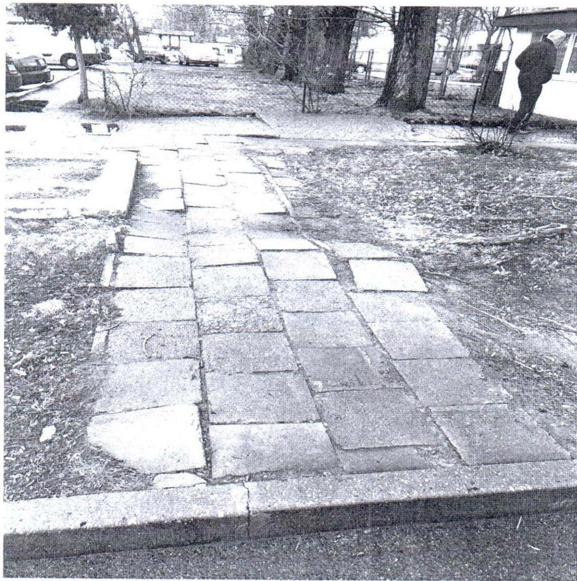
Chodnik do demontażu przy ul. Medycznej na działce 526/9
