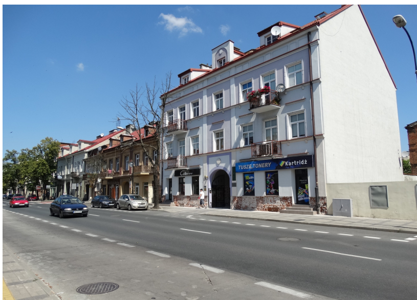
Fot. 2 Budynki wpisane do ewidencji zabytków, przy ul. Kwiatka (E19 i E20), Anna Pustowska, 2018 r.
