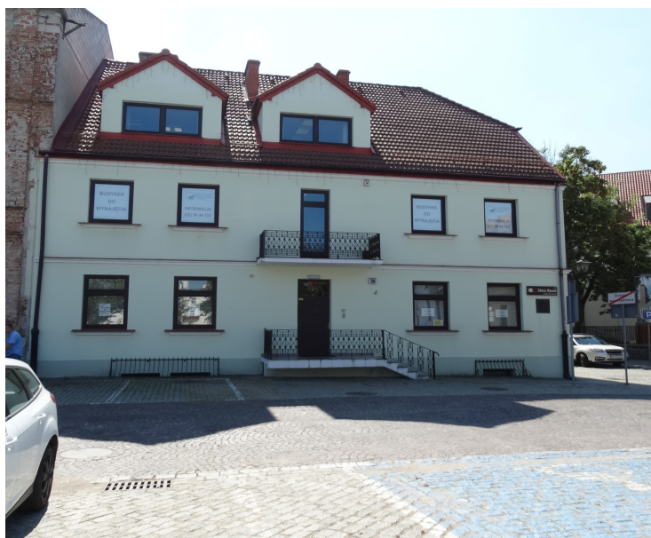
Fot. 4 Budynek wpisany do ewidencji zabytków - piwnica, przy pl. Stary Rynek (E16), Anna Pustowska, 2018 r.
