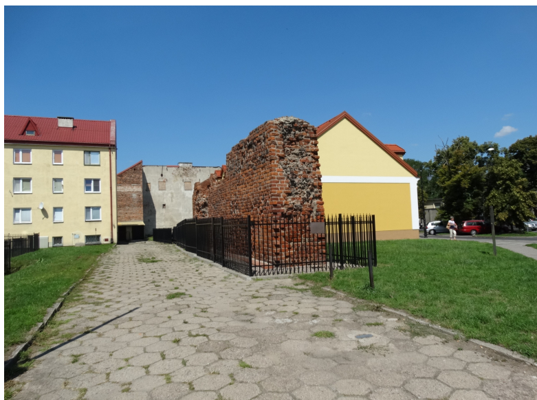
Fot. 3 Obiekt wpisany do rejestru – mur kazimierzowski przy ul. Bielskiej (R19), Anna Pustowska, 2018 r.
