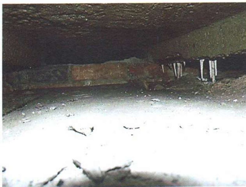
Fot.8 Korozja powierzchniowa płyt warstwowych w przekryciu dachu wyższej części budynku
