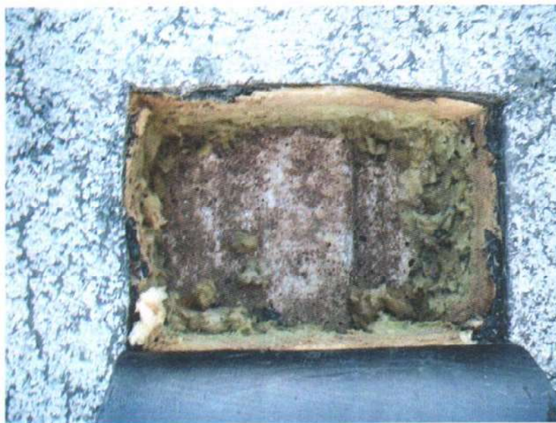
Fot.8 Korozja powierzchniowa płyt warstwowych w przekryciu dachu wyższej części budynku
