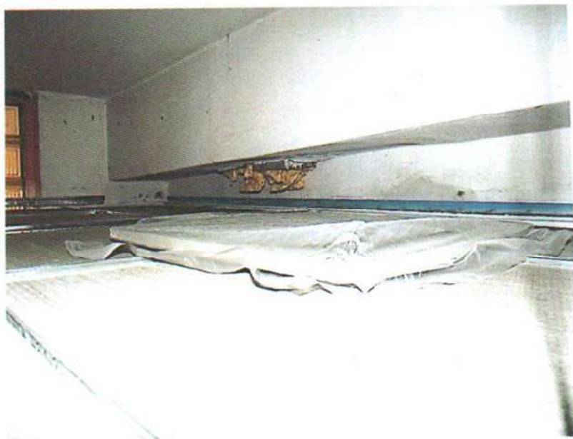
Fot 10 Zabity pianka poliuretanową kanał odłączonej wywiewki wentylacji grawitacyjnej
