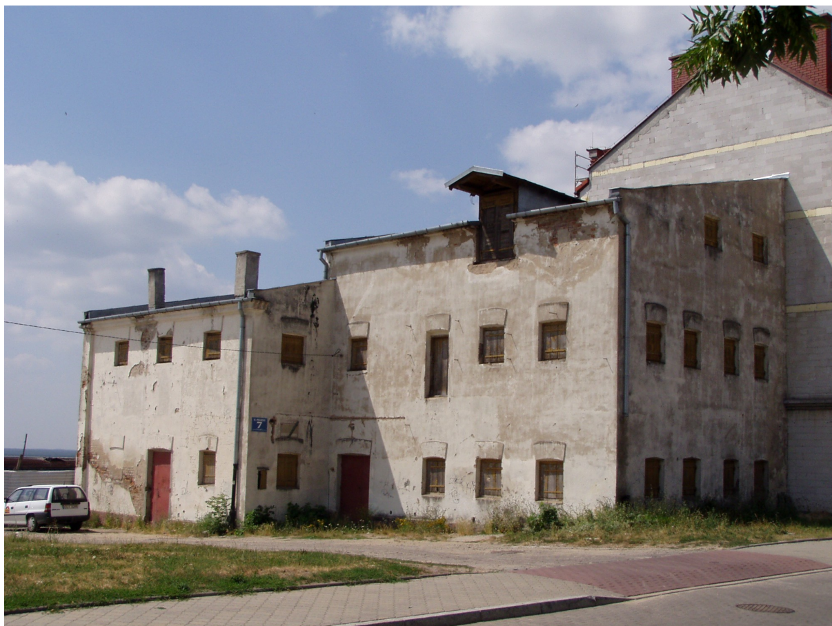
Fot. 9. Spichrz przy ul. Piekarskiej 7, stan na rok 2006
