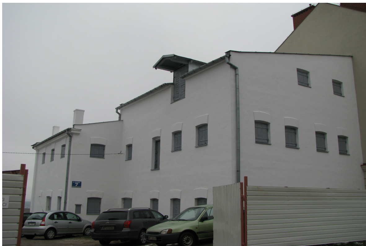
Fot. 10. Spichrz przy ul. Piekarskiej 7, stan obecny
