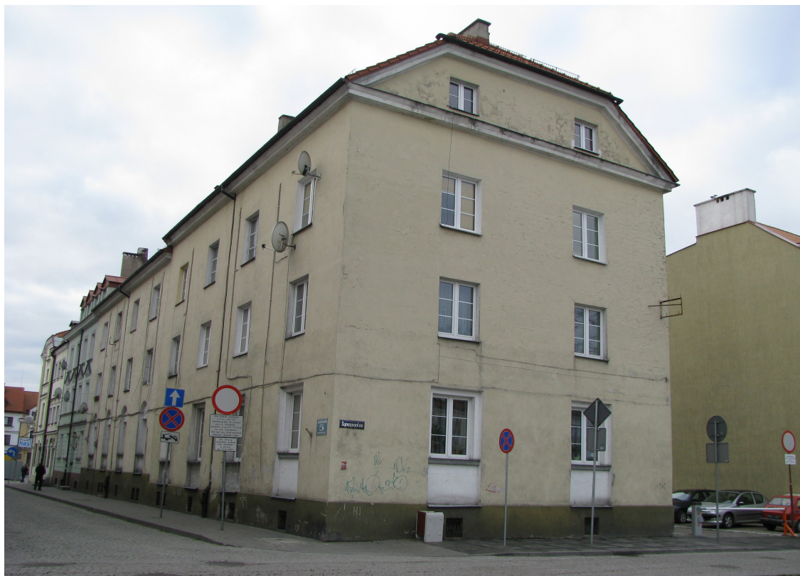
Fot. 14. Budynek przy ul. Jeruzolimskiej 5, stan obecny
