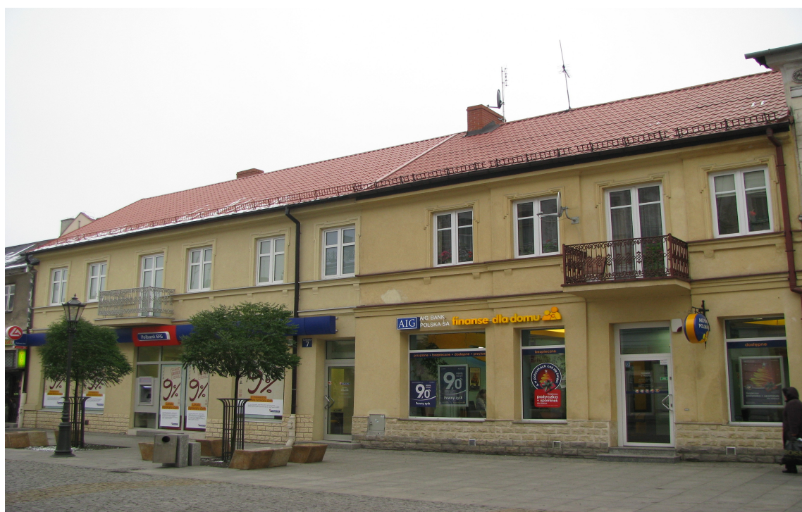
Fot. Nr 13. Budynek przy ul. Tumskiej 7, stan obecny
