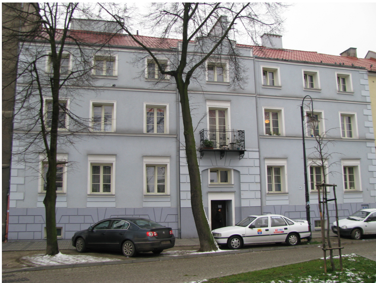
Fot. 3. Budynek przy ul. Kwiatka 11, stan obecny
