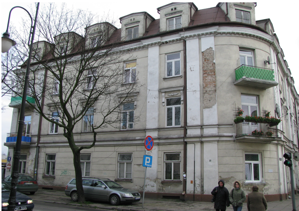
Fot. nr 15. Budynek przy ul. 1-go Maja 4, stan obecny
