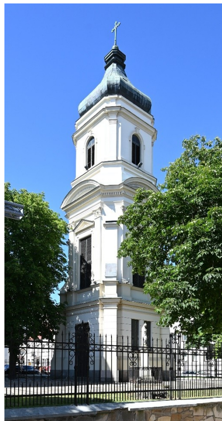
Il. 7. Płock, Dzwonnica przy kościele pw. św. Bartłomieja, fot. M. Horbowicz, 2025
