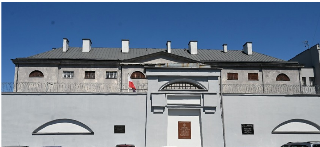
Il. 24. Płock, ul. Sienkiewicza, budynek więzienia, tzw. „stare” więzienie , fot. M. Horbowicz, 2025
