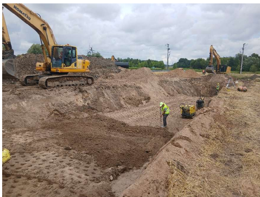
Rysunek 3 Prace budowlane prowadzone w ramach budowy Nowej Przemysłowej (lipiec 2026 r.)
