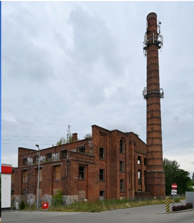
Il. 29. Płock, ul. Kolejowa 8, d. Elektrownia miejska, fot. M. Horbowicz, 2025
