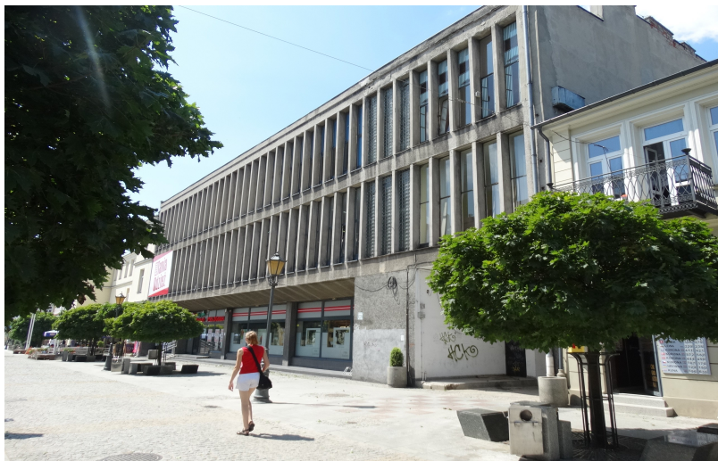
Fot. 3 Dobro kultury współczesnej - budynek dawnego Spółdzielczego Domu Handlowego, obecnie budynek handlowy przy ul. Tumskiej (D2), Anna Pustowska, 2018 r.
