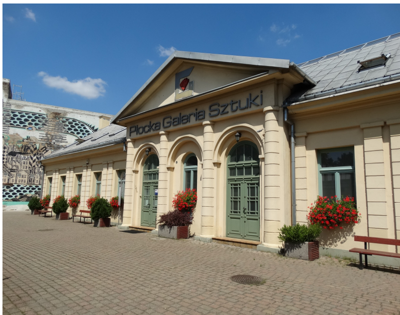
Fot. 1 Budynek wpisany do rejestru – dawna mykwa, obecnie Galeria Sztuki Płocka przy ul. Sienkiewicza (R5), Anna Pustowska, 2018 r.
