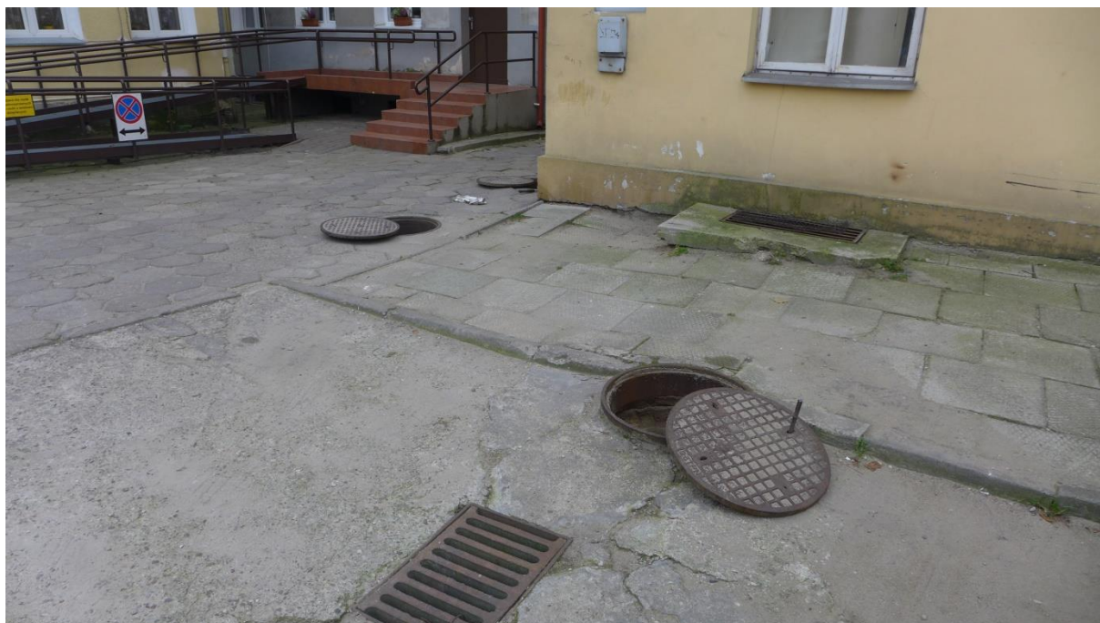
Fot.6. Lokalizacja studni kanalizacji deszczowej i ogólnospławnej w pobliżu narożnika północno-wschodniego budynku
