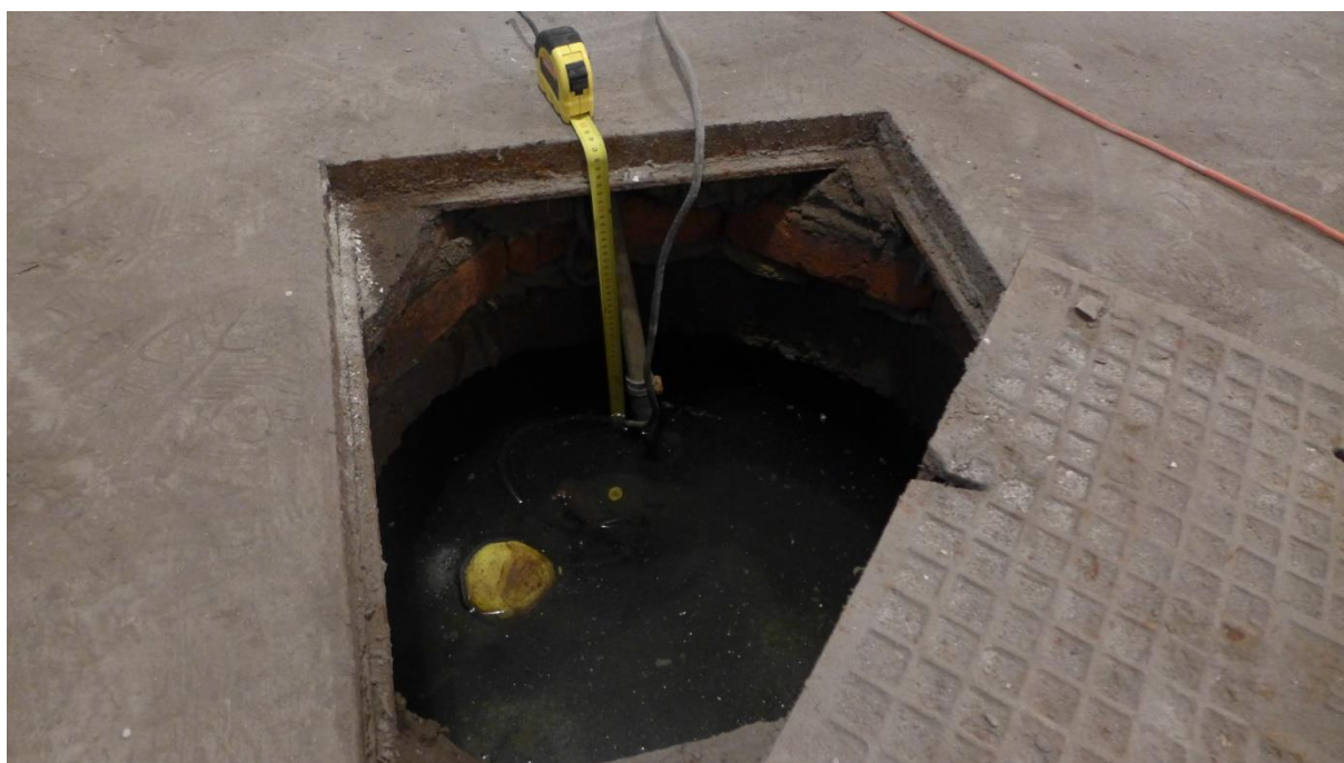
Fot.2. Poziom wody w studni depresyjnej w dniu 30.10.14 wynosił -43cm od poziomu posadzki
